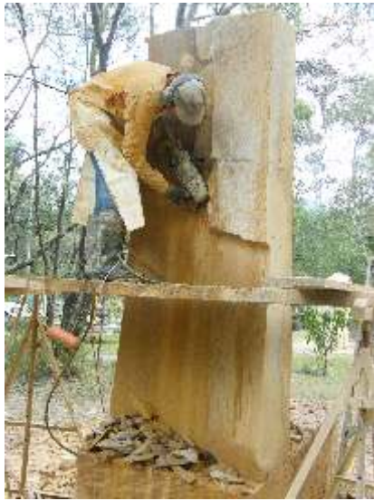
Arbeiten am Durchbruch für das Fenster. Cutting of the gap for the window.
